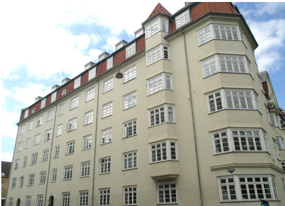
Figur 5. Facader mod gade Vejlegade.
