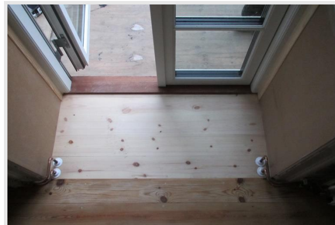
Gulv retableres med fyrretræ fra oprindeligt gulv og ud til altandør.
